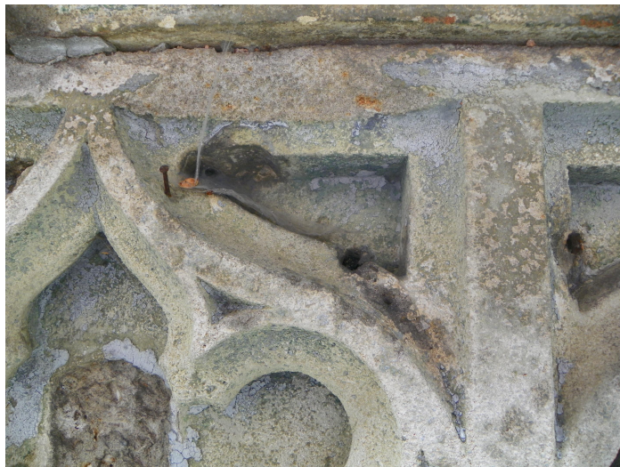
Detaliu nervuri neogotice unde se vad gaurile de montaj ale decoratiei din bronz
