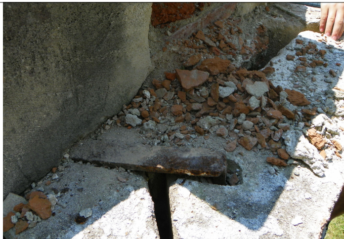
Detaliu imbinare elemente placaj cu scoabe metalice
