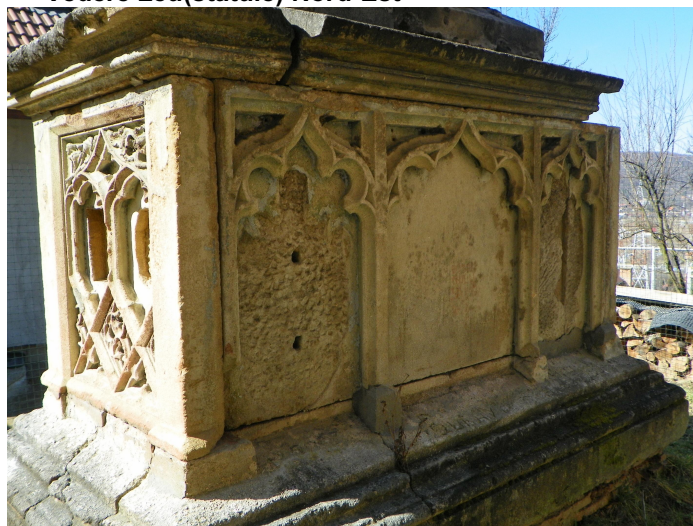
Vedere soculu Sud-Est
