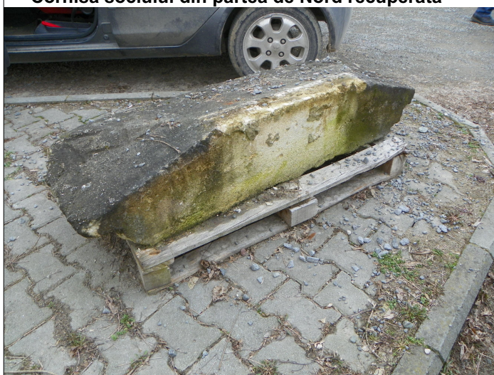
Cornisa soclului din partea de Nord recuperata
