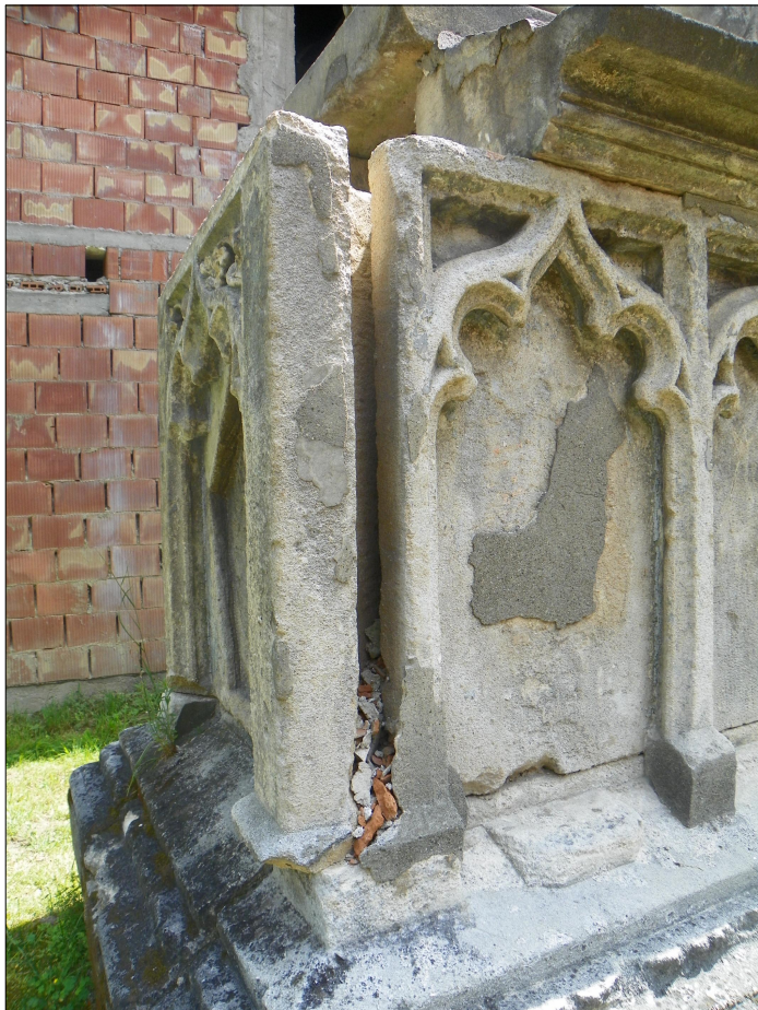
Dislocarea plăcilor soclului în colțul de Nord-Vest în urma unei tentative de furt
