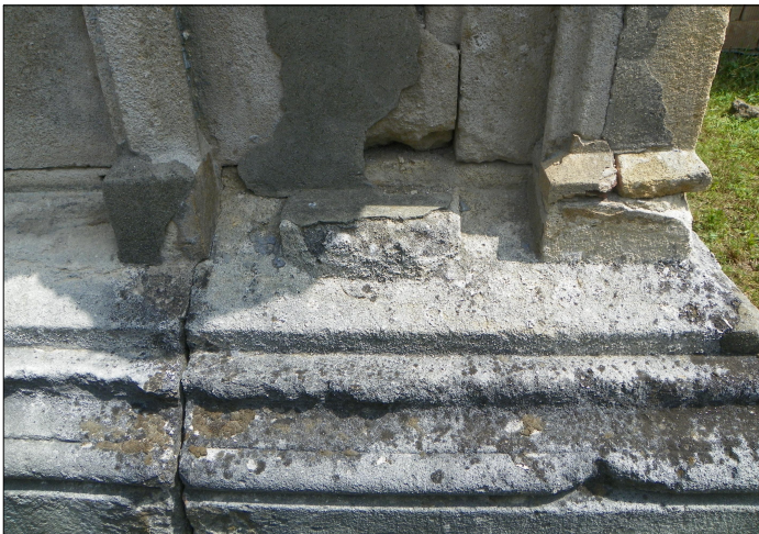
Degradari si reparatii cu ciment soclu
