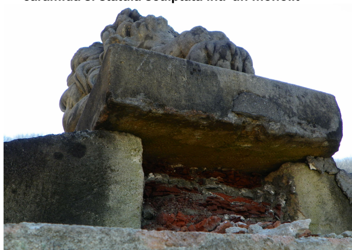
Detaliu alcatuire monument placaj pe miez de caramida si statuia sculptata intr-un monolit
