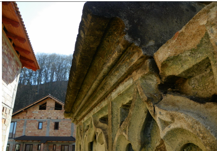
Detaliu soclu imbinare registru median cu cornisa
