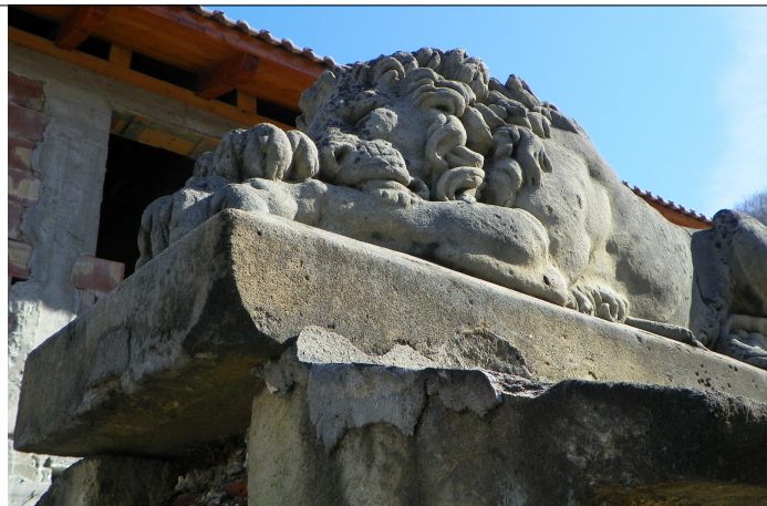
Detaliu alcatuire monument placaj pe miez de caramida si statuia sculptata intr-un monolit
