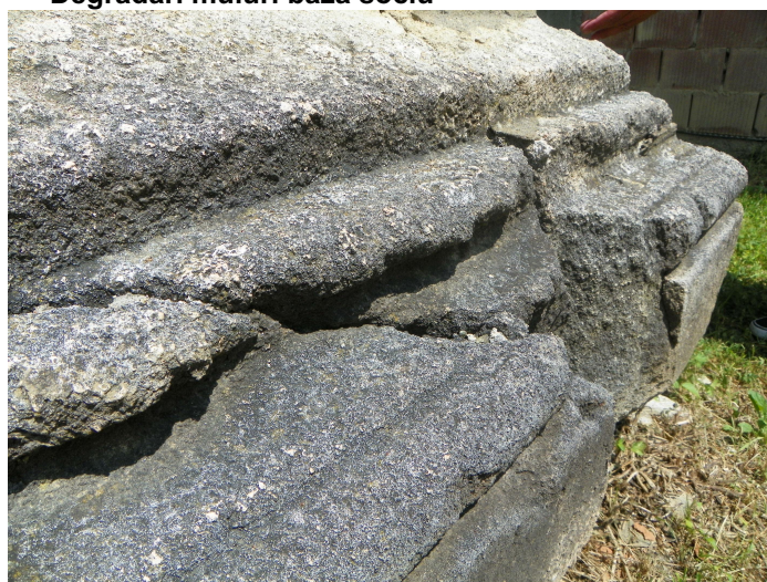
Degradari si lacune modenatura baza soclu
