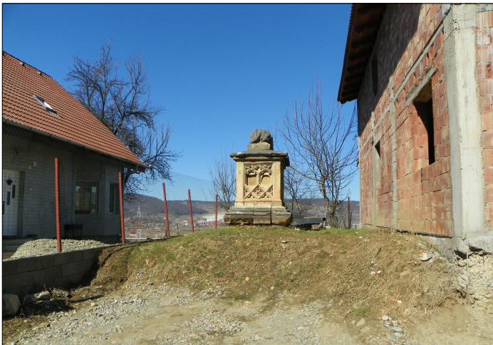
Vedere din strada Dumbravei Sud
