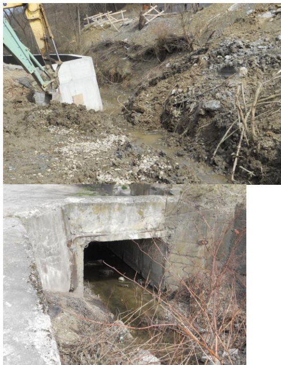
Figura 30 – Strangularea albiei pârâului Câinelui aval de podul de la limita sudică a intravilanului, Figura 31 – Capătul amonte al casetei de pe str. Codrului
