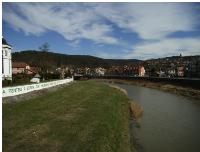
Figura 14 – Malurile Târnavei Mari amonte de pasarela pietonală
