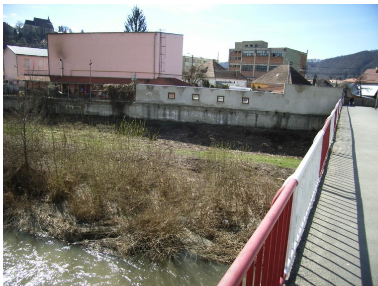
Figura 24 – Vegetație (inclusiv resturi aduse din amonte) pe albia Târnavei Mari amonte de podul de pe str. Libertății
