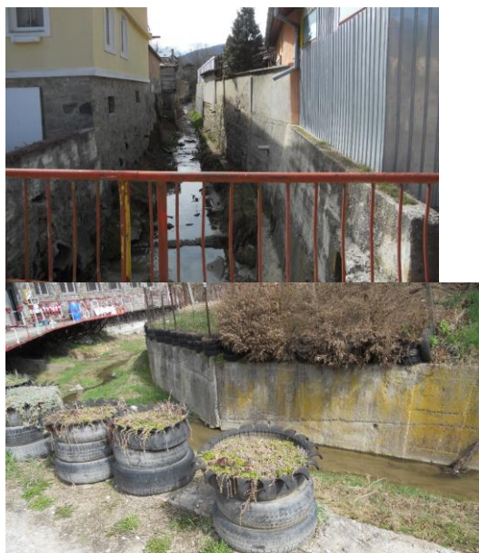
Figura 26 – Albia pâraului Câinelui, amonte de podul de la str. Ceahlăului . Figura 27 – Albia pâraului Câinelui, aval de caseta de pe str. Codrului
