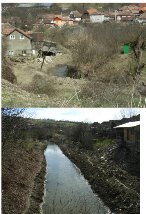
Figura 34 – Lucrări de curățare a albiei pe Șaeș
