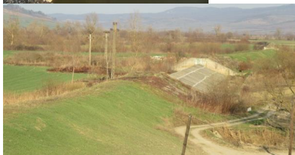
Figura 19 – Barajul Vânători – vedere din aval Figura 20 – Deversor pe digul de compartimentare
