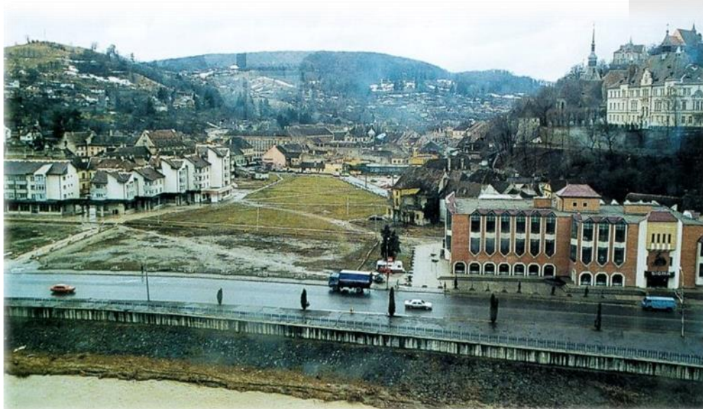
Fig. 11. Zona străzii Morii după demolările ulterioare inundației din 1975
