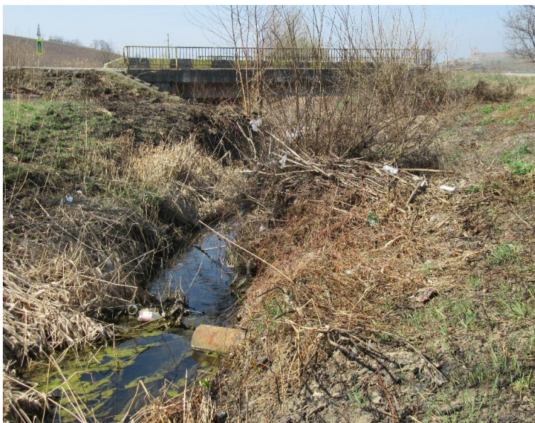
Figura 29 – Pârâul Morii amonte de podul de pe DN 13
