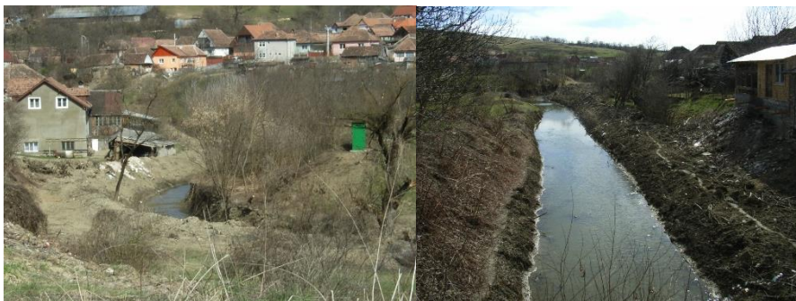
Figura 22 – Lucrări de curățare a albiei pe Șaeș
