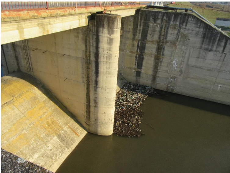
Figura 5 – Barajul Vânători – vedere din aval
