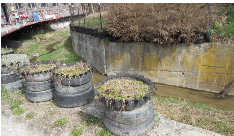
Figura 15 – Albia pâraului Căinelui, aval de caseta de pe str. Codrului
