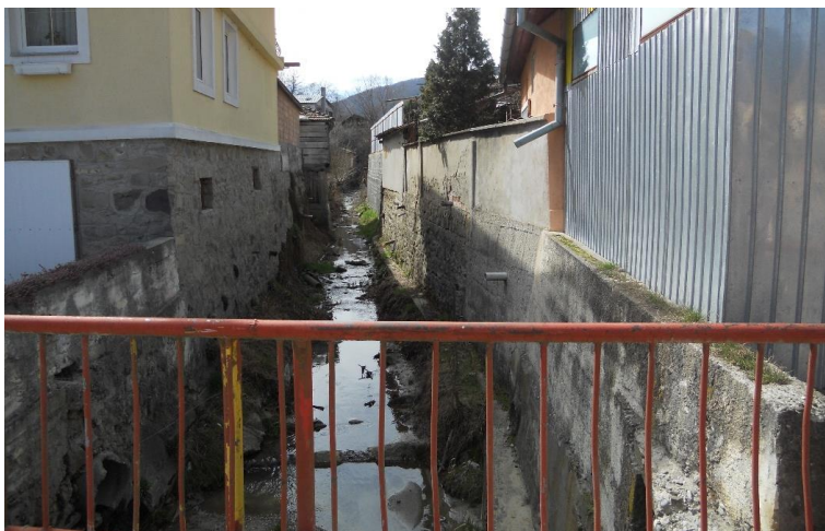
Figura 14 – Albia pâraului Căinelui, amonte de podul de la str. Ceahlăului
