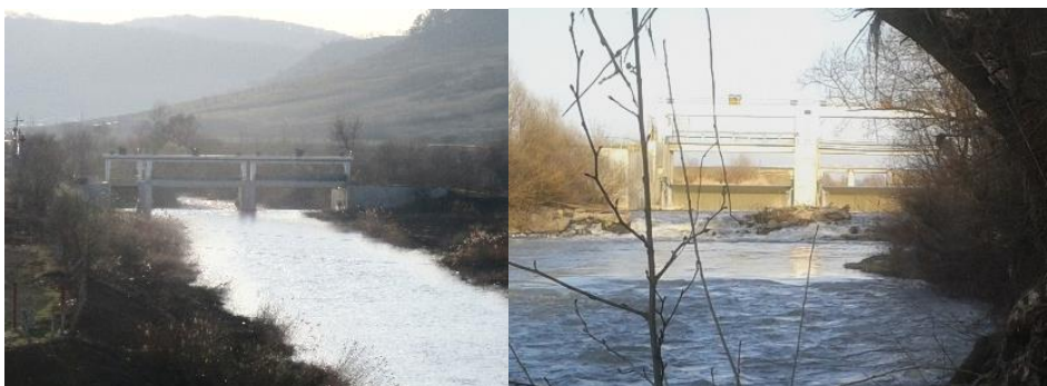
Figura 7 – Stăvilarul Albești - vederi din amonte și din aval
