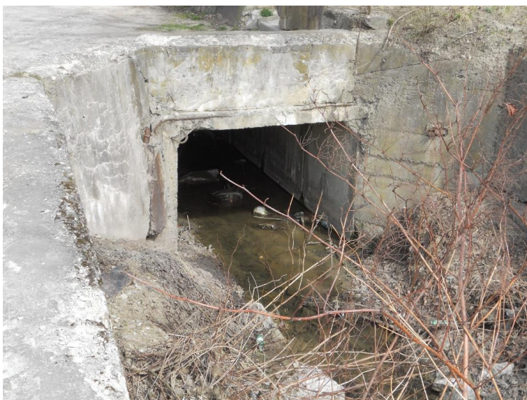
Figura 19 – Capătul amonte al casetei de pe str. Codrului
