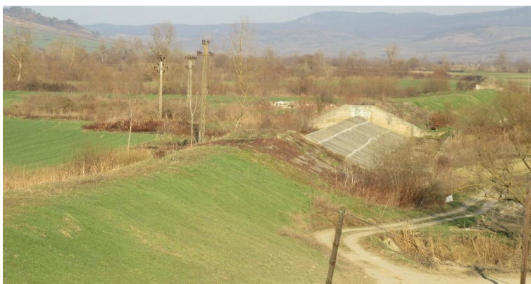
Figura 6 – Deversor pe digul de compartimentare
