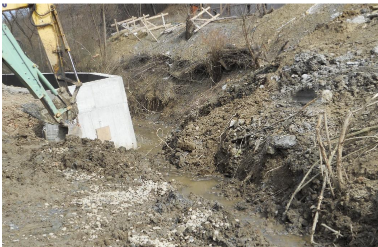
Figura 18 – Strangularea albiei pârâului Căinelui aval de podul de la limita sudică a intravilanului
